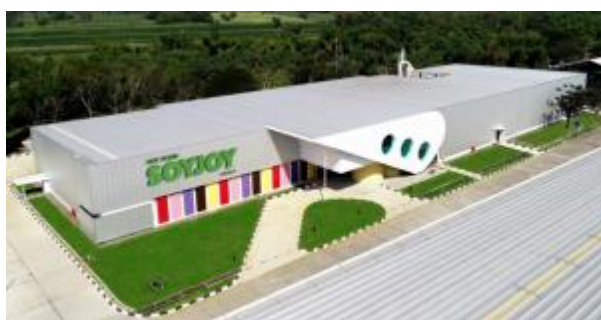
【クジャヤン工場 SOYJOY 棟 外観】
