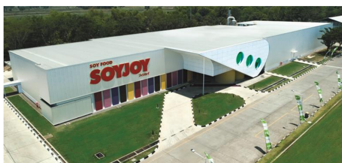
【クジャヤン工場 SOYJOY 棟 外観】
